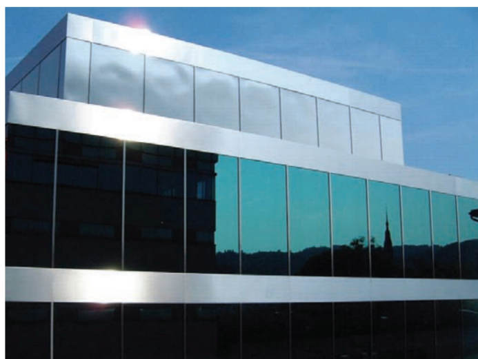
Das 2001 in Betrieb genommene Entwicklungsgebäude in Zofingen.
